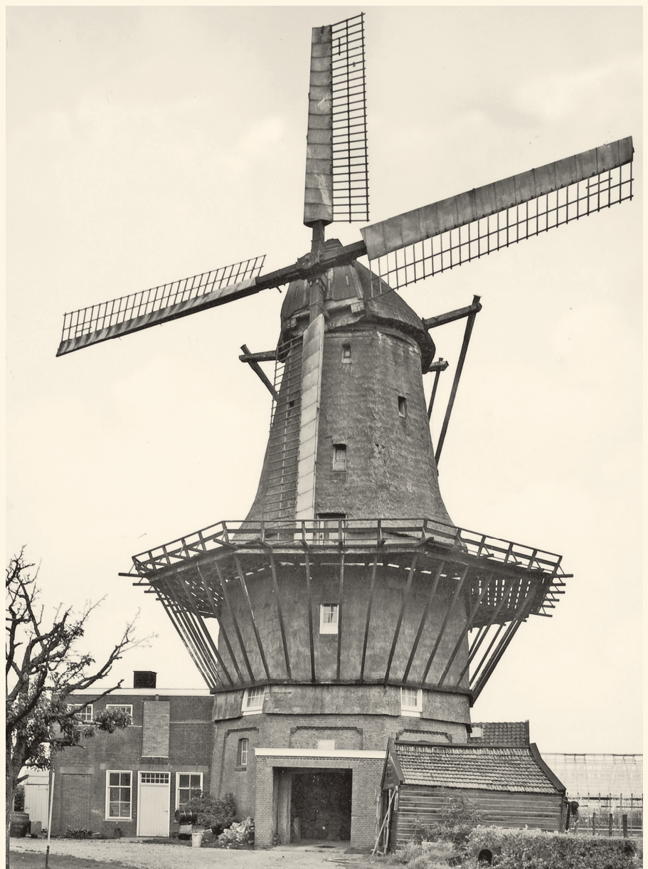
Molen De Krijgsman op een ansichtkaart uit 1959. In het gebouw werd toen nog op motorkracht gemalen. Het windmolenbedrijf was al een tiental jaren eerder stilgelegd, en dat ondanks de Dekker-stroomlijnneuzen die de molen in 1934 had gekregen (collectie Vereniging De Hollandsche Molen).
